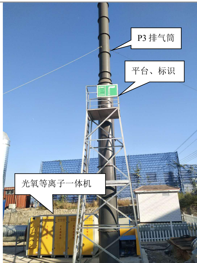
P3 排气筒及沥青混合搅拌及下料工序光氧等离子
