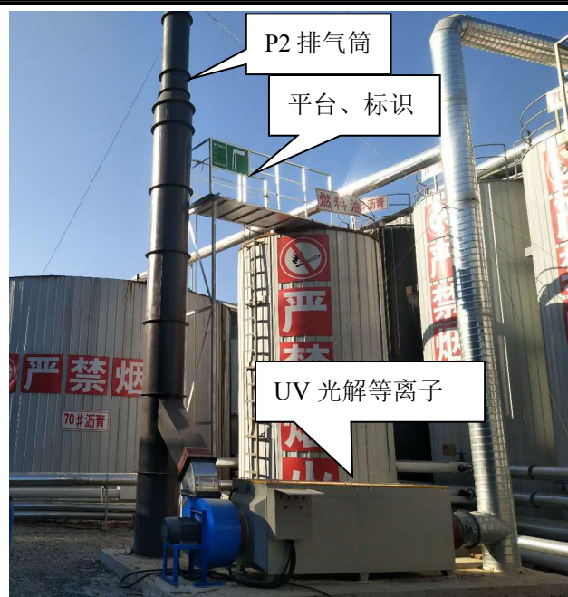
P2 排气筒及沥青储罐 UV 光解等离子一体净化系统
