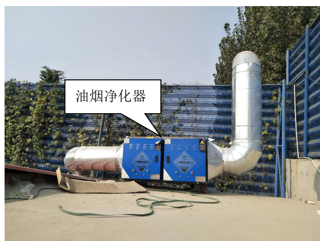
P6 排气筒及油烟净化器
