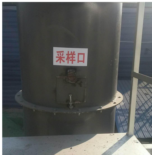
P2 排气筒采样平台及采样口
